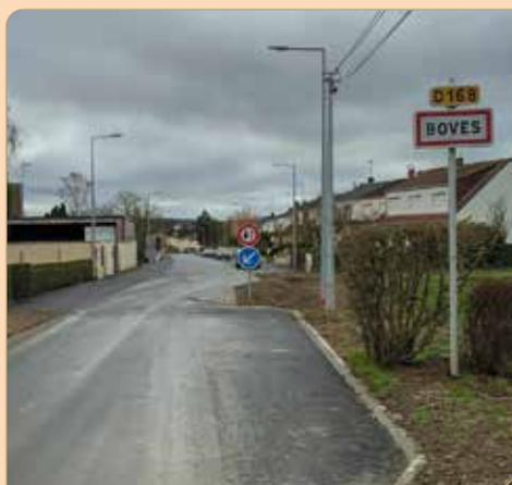
Les travaux d'évacuation des eaux de pluie sont toujours en cours, mais l'enfouissement des réseaux, le remplacement des réverbères ainsi que la réfection de la chaussée et des trottoirs sont quasiment terminés.
