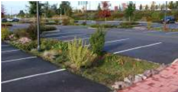
Exemple de mise en oeuvre d'une noue paysagère entre les rangs de stationnement
