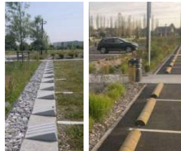
L'installation des butées de parking en cohérence avec les traitements paysagers contribue à la qualité des espaces libres
