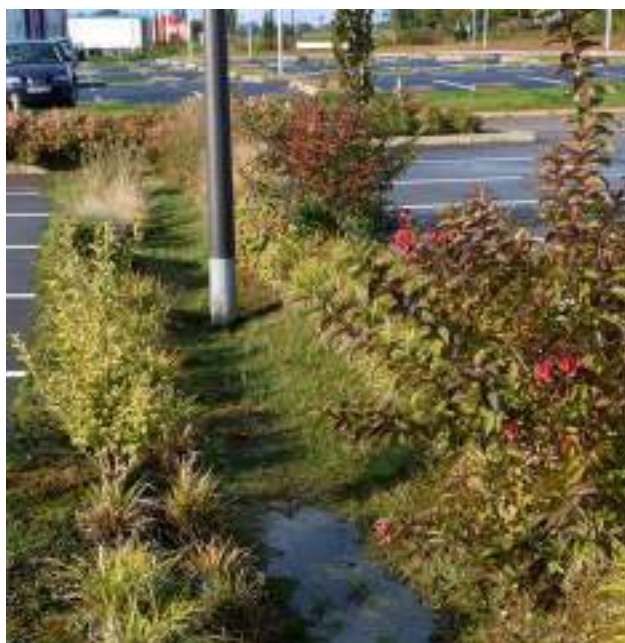
Exemple d'une noue paysagère
