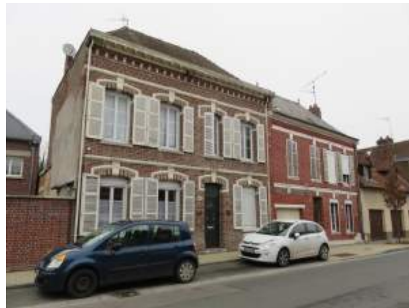
Maison en brique dans le centre-ville de Boves, rue Victor Hugo
