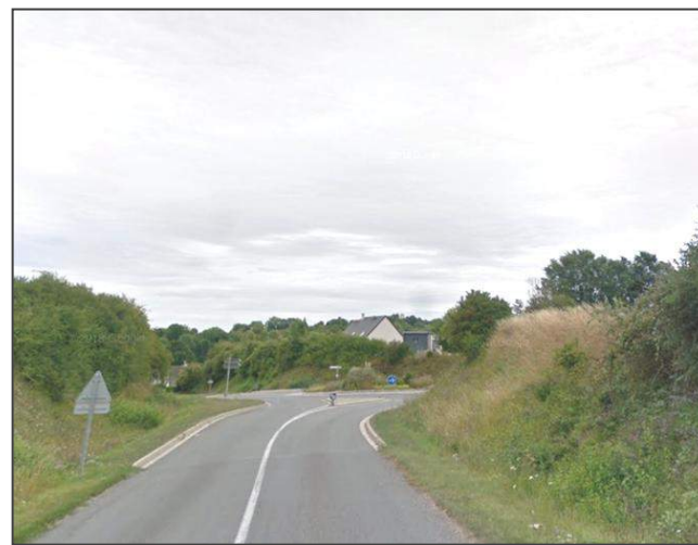
Entrée de ville n°4, par la rue Gaston Lecomte (RD 116), depuis le nord-ouest
